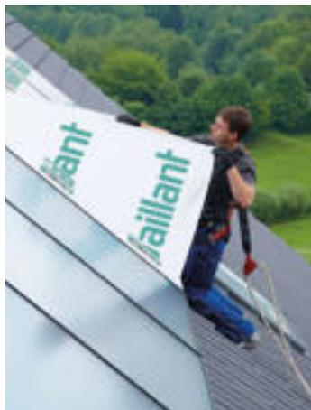
La configuración de la estructura ha sido diseñada para que el montaje se realice mediante el sistema "plug and play" y así minimizar tanto el tiempo de montaje como el nº de piezas a montar. Los soportes incluyen los accesorios de montaje y kits básicos y de ampliación de conexiones hidráulicas.
