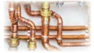
Por ello, las aleaciones de soldadura fuerte se utilizan siempre que el aspecto exterior de las piezas ensambladas sea primordial:
