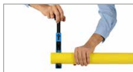
3. Cortar el tubo de forma totalmente recta.
