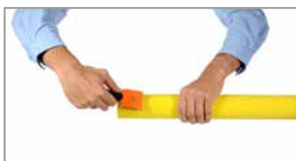
5. Rasar la zona de soldadura del tubo.
