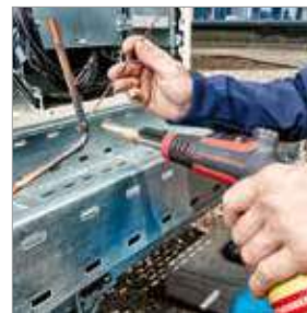
Soldadura fuerte en aire acondicionado y refrigeración
