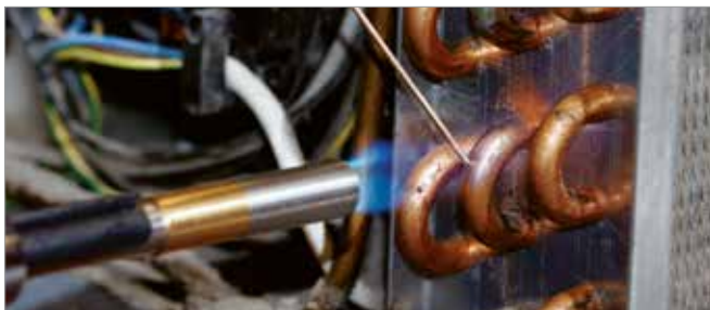
Soldadura fuerte en aire acondicionado y refrigeración
