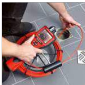
Inspección de sumideros
